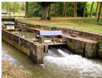
Les écluses initiales et le bassin octogone furent abandonnés pour les usages de la navigation. Le pourtour du bassin est alors devenu une rigole de décantation permettant aux eaux de la rigole de la Plaine de déposer leurs alluvions. Vous découvrez au bout de cette rigole, l'ouvrage d'alimentation et de régulation qui distribue les eaux de la Montagne Noire dans le bief de partage des eaux.
