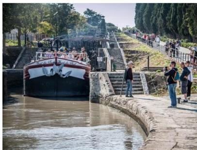
L'ouvrage le plus spectaculaire du Canal du Midi : **les 9 écluses de Fonseranes** à Béziers (PK206) ! Composé à l'origine de neuf écluses en enfilade, l'Octuple (succession de 8 bassins en escalier, de forme ovoïde) permet de franchir, sur une longueur de 300 m, un dénivelé de 21,5 m. Aujourd'hui, seules 7 écluses sont encore en service. Juste à côté, la pente d'eau devait permettre le franchissement de dénivelés importants pour des péniches de grand gabarit.
