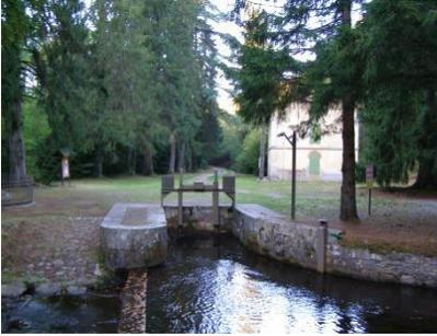
Les vannes de prise d'eau, les vannes de régulation et les épanchoirs : pour contrôler les débits, voire vidanger les rigoles par l'intervention du personnel de VNF. Jadis cela se faisait par des systèmes à manivelle, maintenant par télésurveillance vidéo et vanne électromécanique.
