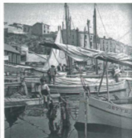
Les travaux du port de Sète ont commencé par l'édification de la jetée Saint-Louis.
